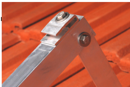
9: Säkra upplagsvinkel med stödvinkel med bult
