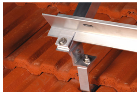
10: Montera stödskenor i klämlisterna.
